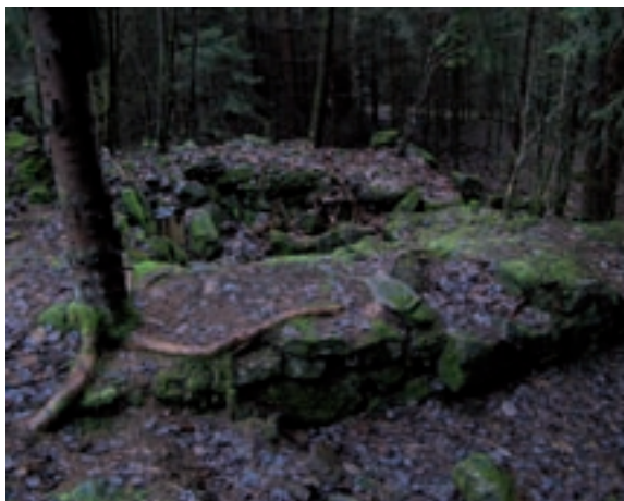
En del av grunnmuren på Østre Guldsmeden. Foto Lise Henriksen
