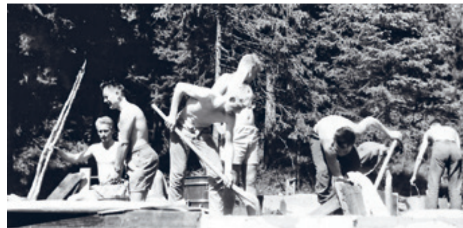
Arbeid med en grunnmur i 1961, Odvar Brænden, Kjell Evert Kristiansen, Kjell Gulbrandsen og Einar Nielsen.
