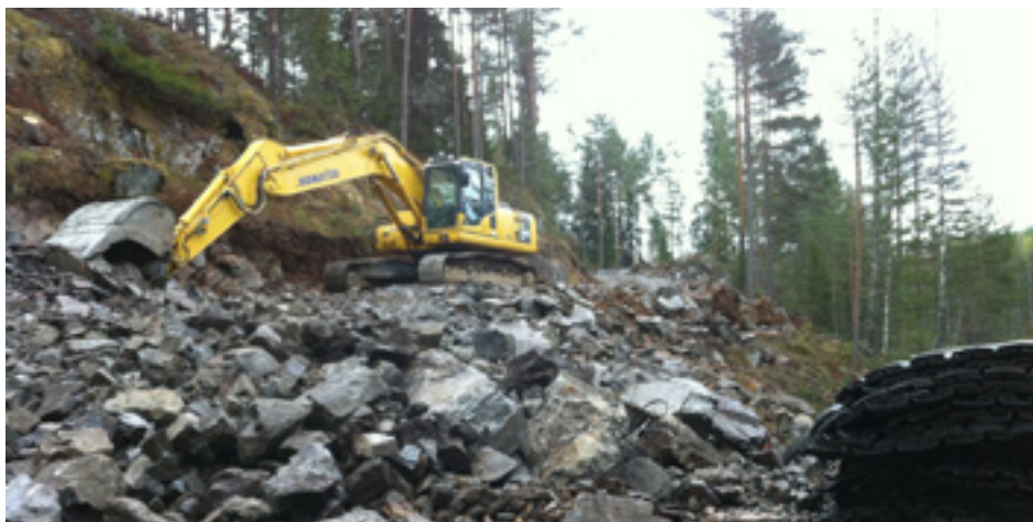
Turstien ved Myrdammen ble gjenstand for langt mer omfattende anleggsarbeid enn det som var omsøkt. Foto: Johan Ellingsen
