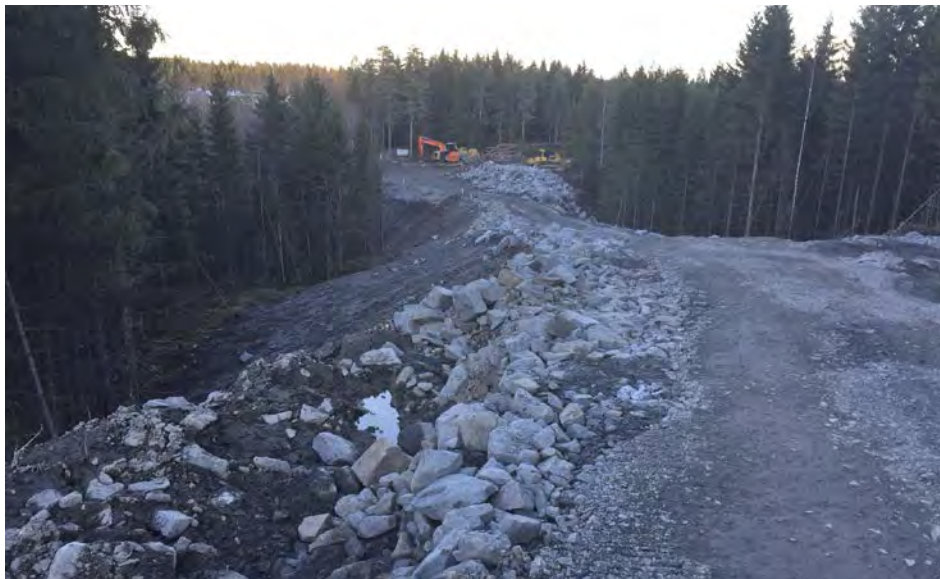
Tusenvis av kubikkmeter med masse dumpes under bygging av veien til Marikollen fra Blystadlia. Foto: Johan Ellingsen.
