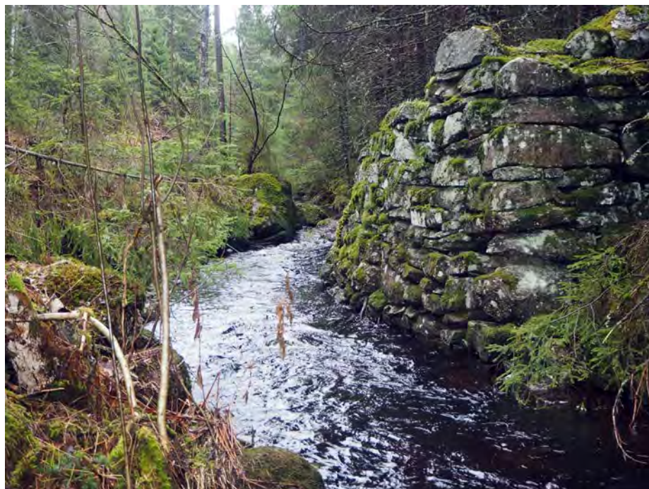
Demningen ved Skjelbreia ble bygd for å lette fløtingen av tømmer til Bindingsvann. Restene etter demningen er fortsatt et imponerende minne om tidligere tiders slit. Foto: Bjarne Røsjø
