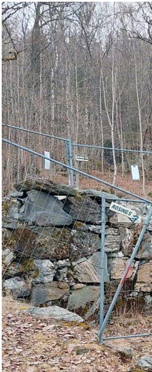
Sikring av kjellermurene, april 2022. Foto: Lars Rogstad
