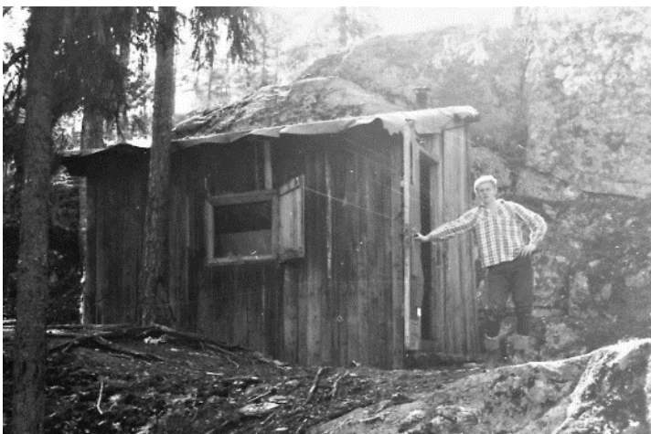
Rester etter Spinnheim og den seinere speiderhytta, 1965. Isolasjon i form av grov glassvatt sydd inn i svartpapp tyder på at den var i bruk tidlig på 1950-tallet. Foto: Harald Hartmark.
