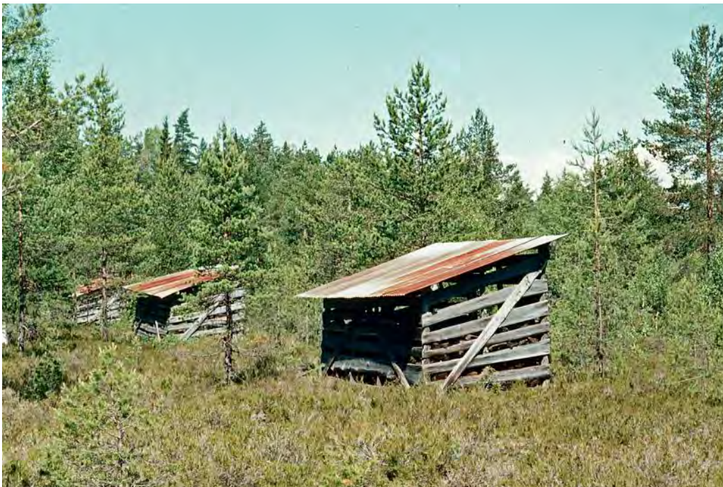
Tørkeskurene på Ødegårdsmosen, 1950-tallet (muligens seinere). Legg også merke til at myra er i ferd med å gro til, som effekt av dreneringen som torvuttaket innebar. Foto: Sigurd Senje
