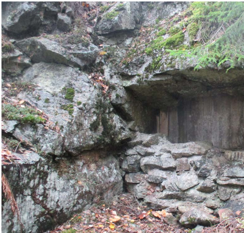
Feltspatgruva i Dalsåsen var ikke drivverdig, og i dag er gruveinngangen stengt med stein og en betongmur.
