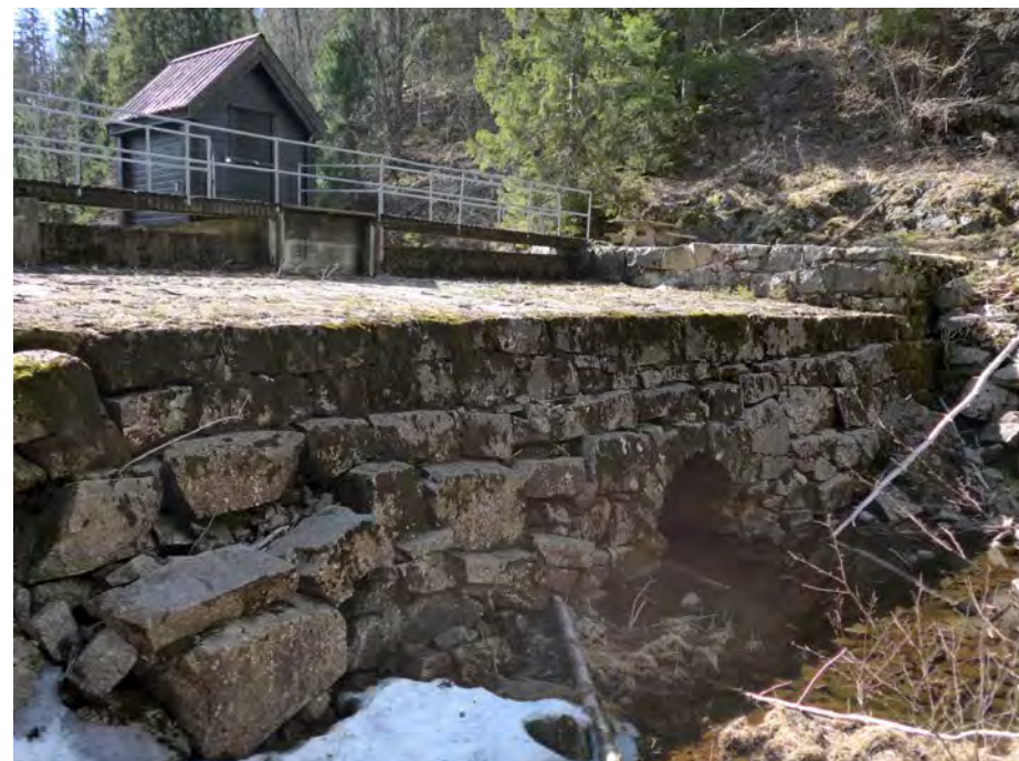
Den gamle demningen ved Fri-Elvåga som skal fjernes og erstattes av en betongdam. Foto: Bjarne Røsjo
