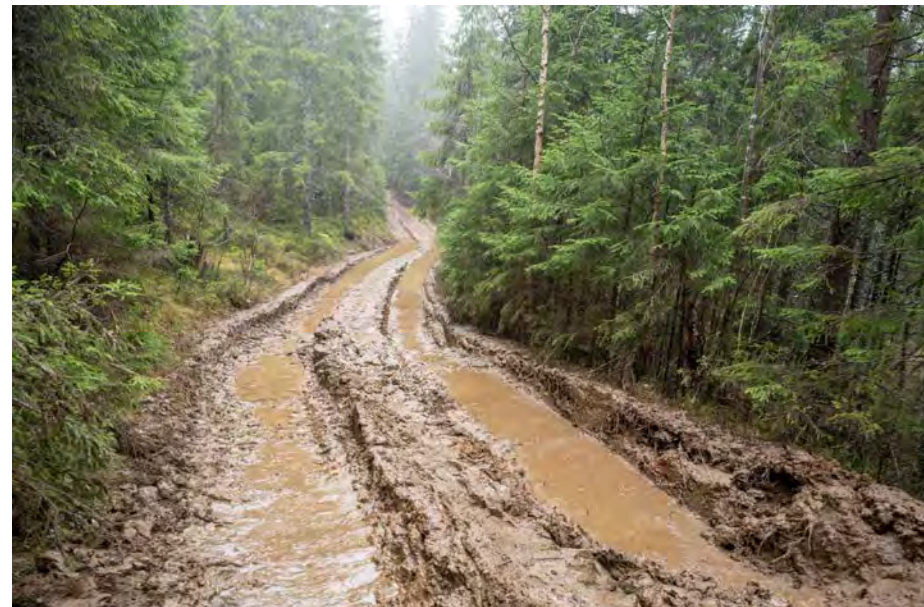
Hogsten førte til at Brudalsveien, den viktigste innfartsåren til Østmarka fra Rælingen, ble ødelagt. Foto: Bjørnar Thøgersen.
