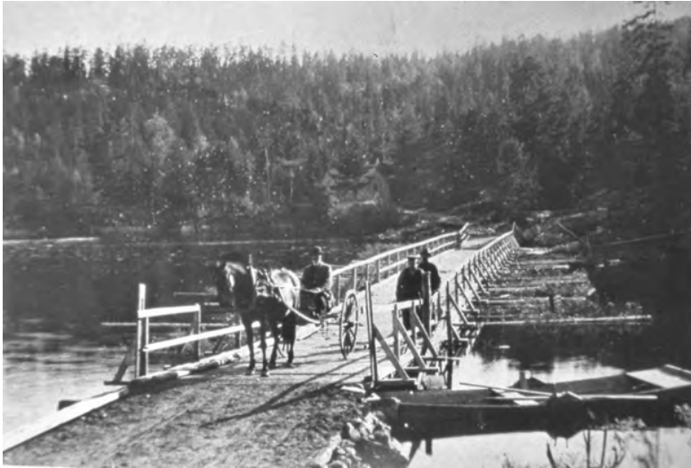
Flytebrua over Mosjøtranga. Brua kunne sveives til side når det ble fløtet tømmer fra Mosjøen til Rausjø. Ca 1910. Fotograf: P. A. Ness, bruksfullmechtig Rausjø
