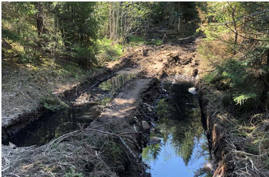
Store kjøreskader i Brudalen etter tømmertransport. Foto: Bjarne Røsjø.
