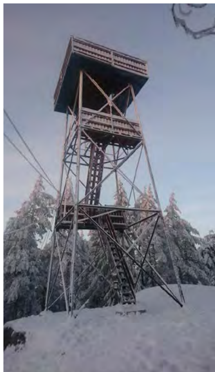
Tårnet slik mange kjenner det i dag, stod ferdig i 1952 og ble rehabilitert høsten 2018.
