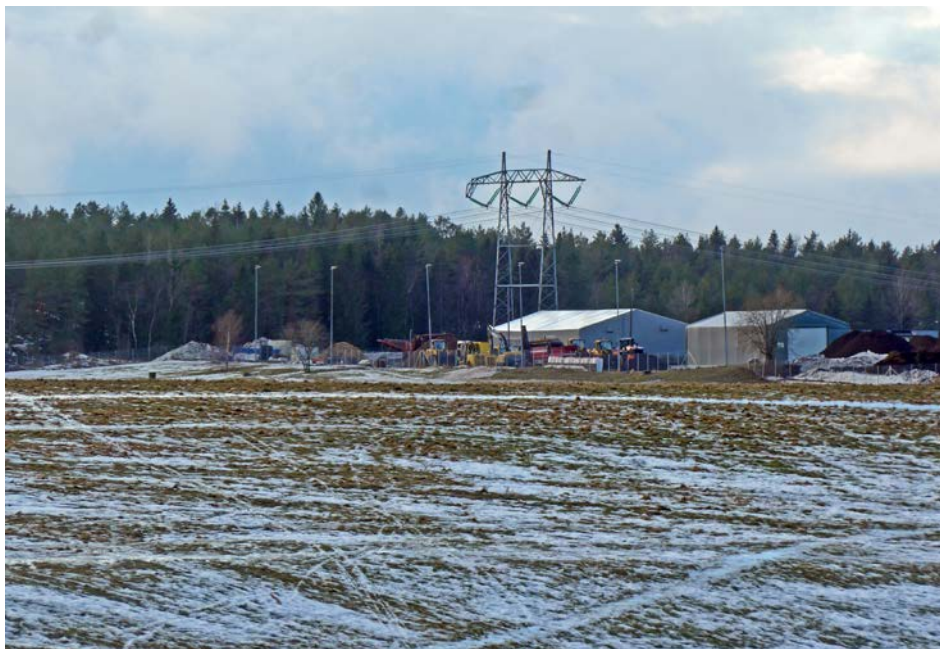
Grønmo-området er uferdig i dag, men skal utvikles til «Frognerparken på østkanten». ØV har derfor kjempet imot at en trollstor trafostasjon skal ødelegge området. Foto: Bjarne Røsjø.
