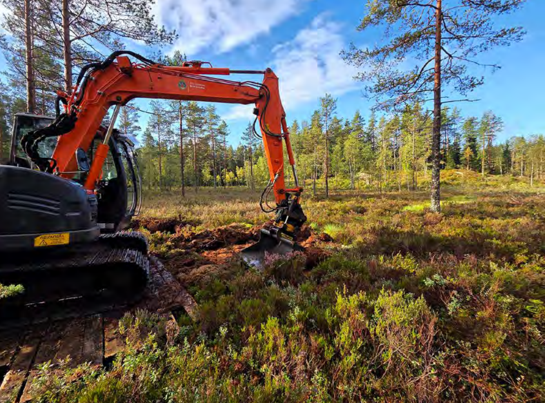
Gravemaskin i arbeid med restaurering på Stupinnmåsan ved Hanåaveien i Østmarka. Foto: Øystein Kolseth.
