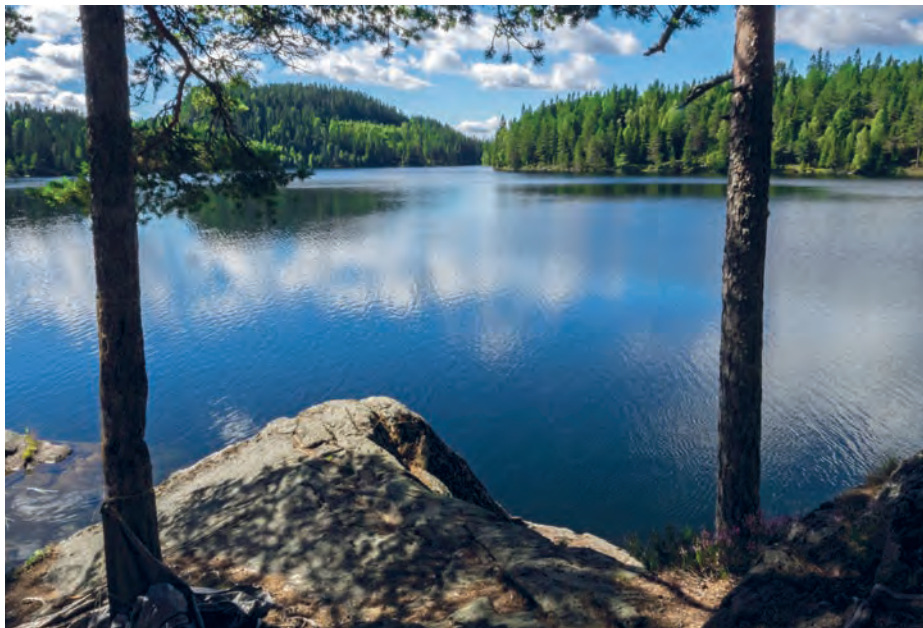
Rælingen kommune sørget for at demningen ved Ramstadsjøen ble restaurert, slik at vannstanden ble bevart. Foto: Bjørnar Thøgersen.
